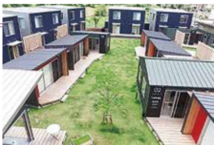
▲写真1 交流会を開催する中庭を囲んで住居やオフィスが配置されている「ドットツリー修善寺」
