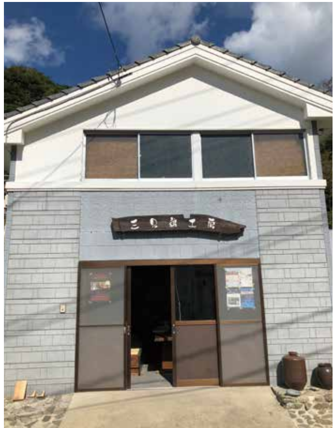
▲三兄弟工房の外観
