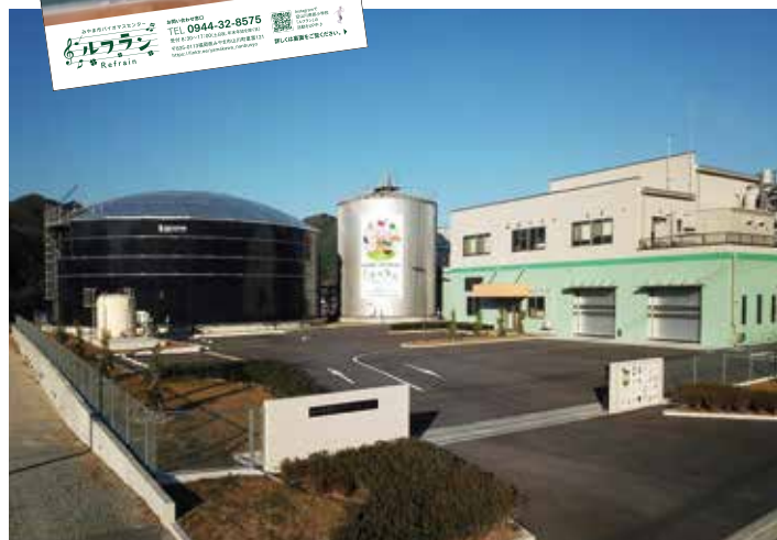
バイオマスセンター「ルフラン」
