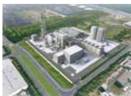
バイオマス発電所
