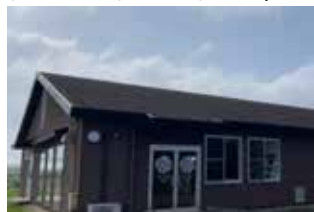
遺跡の中にある平屋施設
