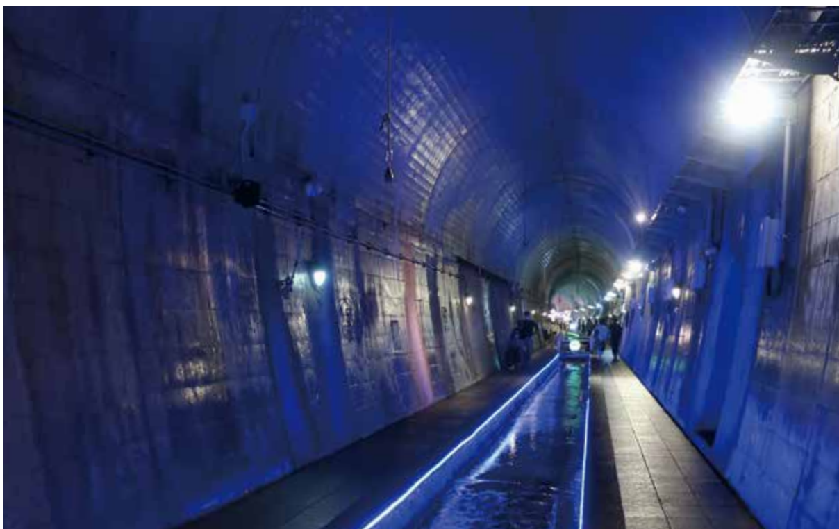
▲トンネル内の様子
