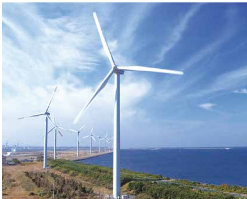
図3.クリーンなエネルギーとして注目の響灘「風力発電施設」
