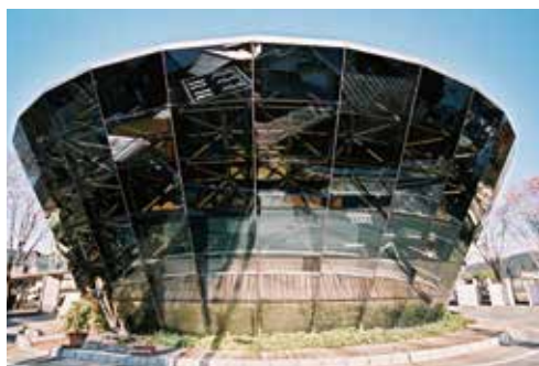
道の駅「小国」ゆうステーション
