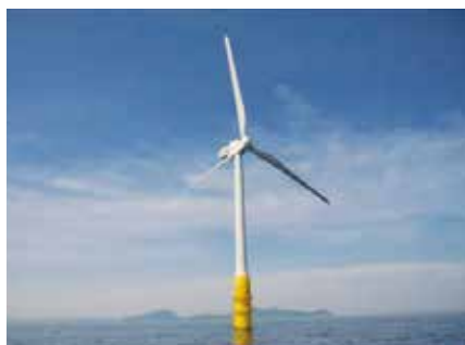
写真5 世界初のハイブリッドスパー型浮体式洋上風力発電
