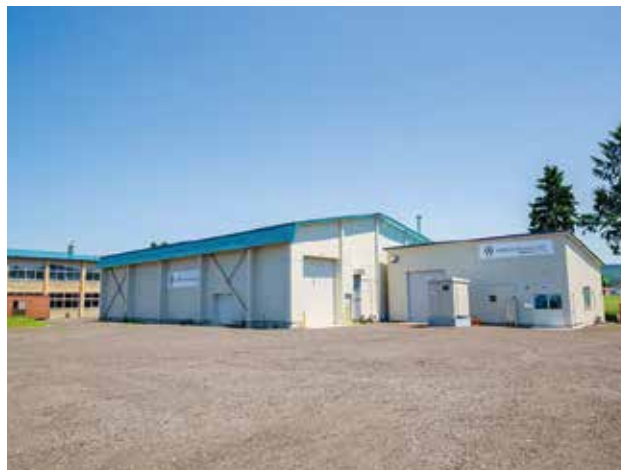
▲写真4 搾油設備が設置されている廃校施設
