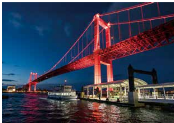
2022年8月、新たに日本夜景遺産に認定された「若戸大橋」のライトアップ
