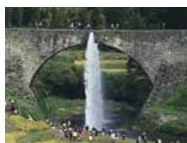
▲現在、通潤橋上の通行は放水日のみで有料です
