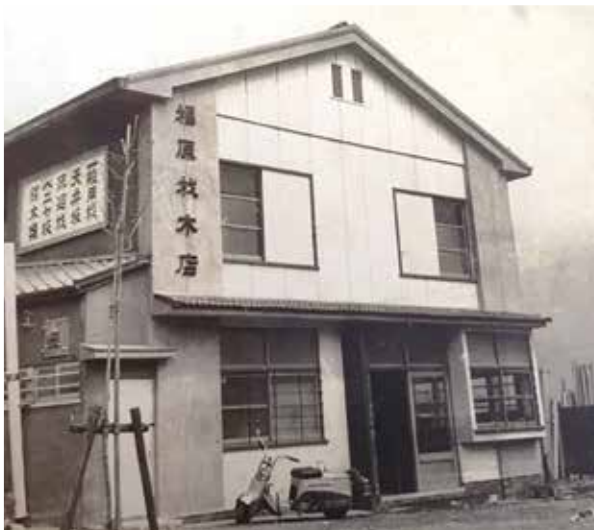
昔の福原材木店の外観
