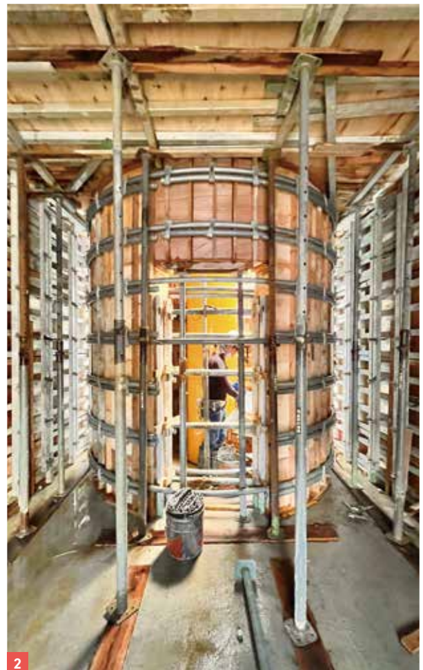
1.2023年3月に竣工した本社ビル／2.建物の躯体となる型枠工事／3.型枠工事の技術は正確性が求められる／4.日本建設(株)の安全大会にて安全優秀賞を受賞
