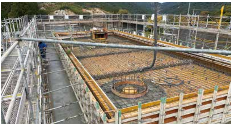
型枠工事現場の様子
