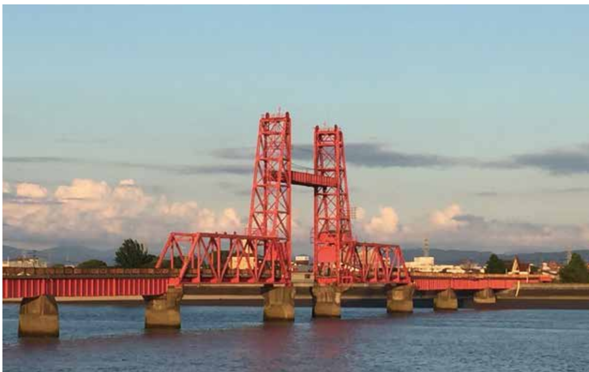
▲筑後川昇開橋
