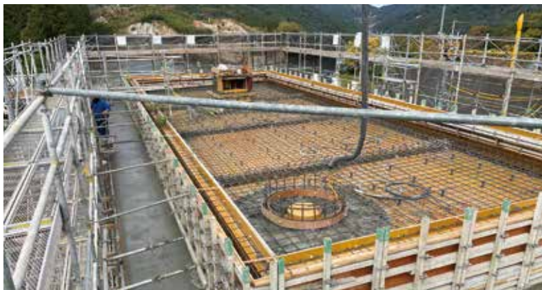
型枠工事現場の様子
