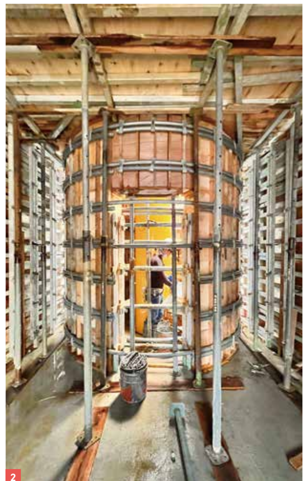
1.2023年3月に竣工した本社ビル／2.建物の躯体となる型枠工事／3.型枠工事の技術は正確性が求められる／4.日本建設の安全大会にて安全優秀賞を受賞
