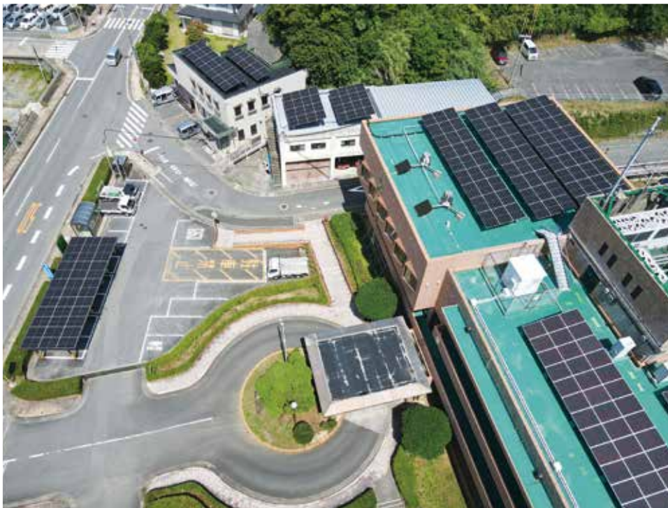
太陽光発電設備の施行実績(西海市役所)
