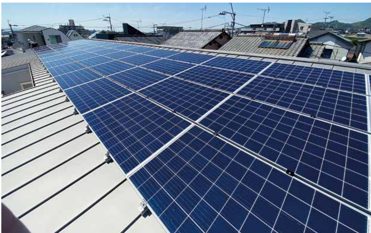
屋根貸して事業の工事風景
