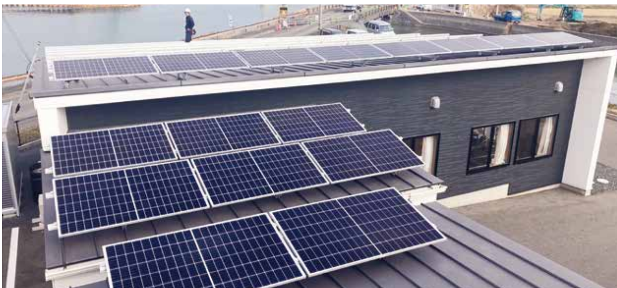
太陽光発電設備設置工事
