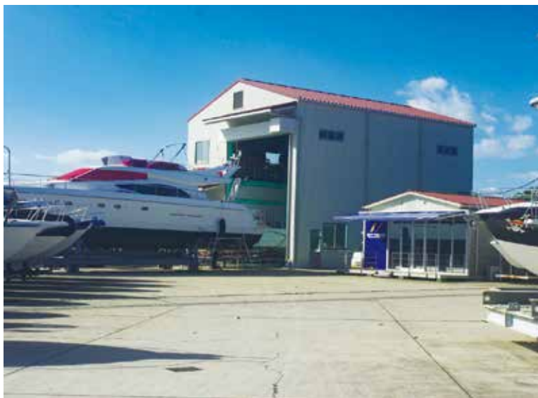
サービスセンターパール（フィッシャリーナ天草（マリーナ）内）のサービス工場
