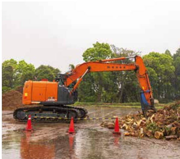
遠隔操作で動く無人のバックホー
