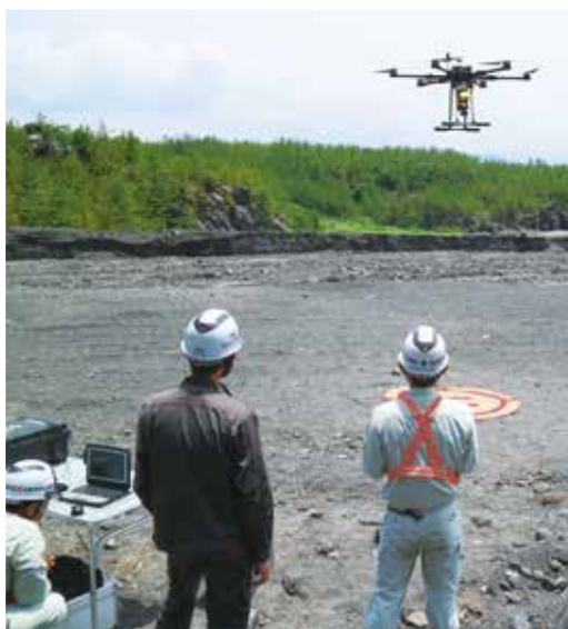
ドローンによる3次元測量の様子
