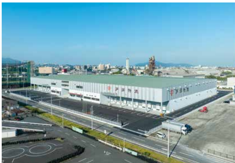
2024年9月竣工 戸畑物流株式会社 西港センター
