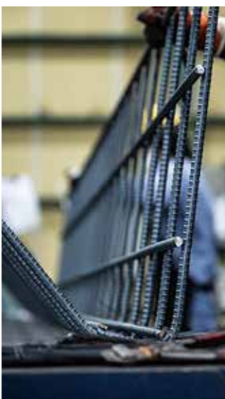
住宅基礎ユニット鉄筋の加工
