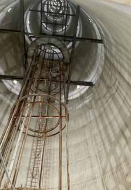
無線塔内部の様子 筆者撮影
