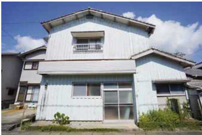
「てとば美術館」に改修する前の元写真館だった建物
