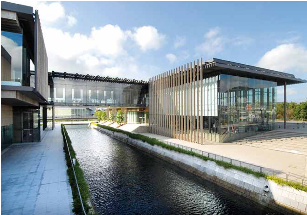
長崎県美術館建物外観（写真：長崎県美術館）
