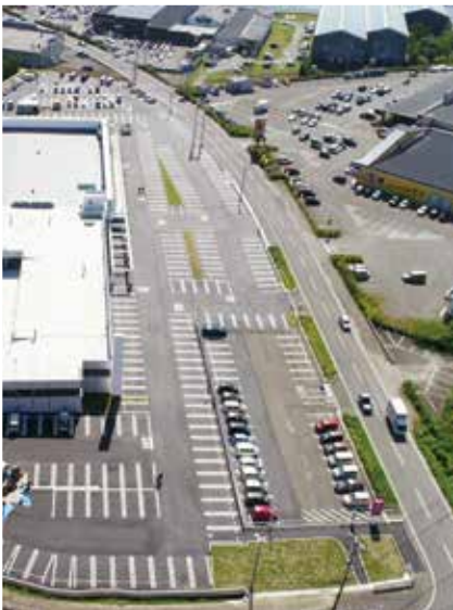
当社の施工例（舗装部分）
