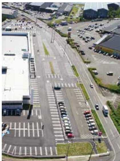
当社の施工例（舗装部分）
