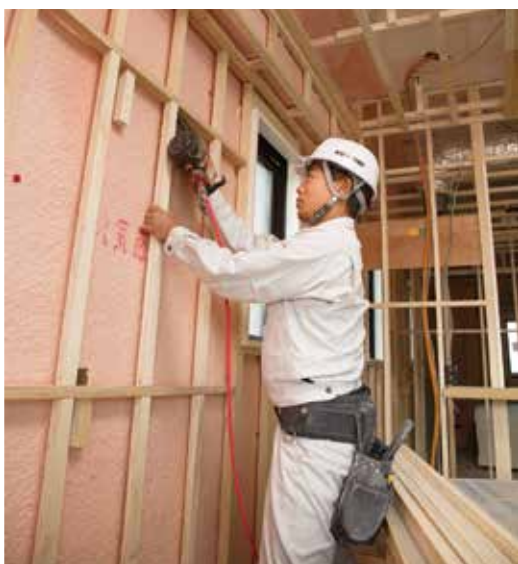
技能工による造作作業
