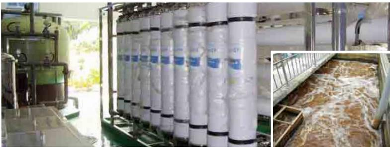
▲深圳で施工された汚水の再利用設備。900トン/日程度の処理能力を有する。
