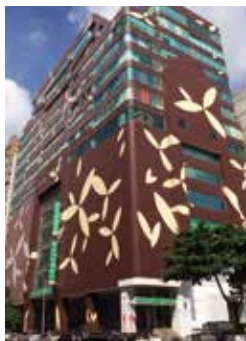
▲台湾支店(台中)入居ビル外観
