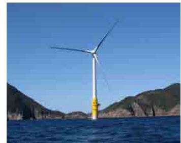
五島桧島沖合に設置された「浮体式洋上風力発電施設」は、巨大な風車を使って次世代の海洋再生エネル ギーを検証する実証フィールド。
