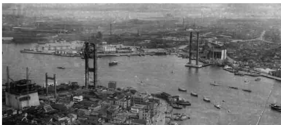
▲建設中の若戸大橋
