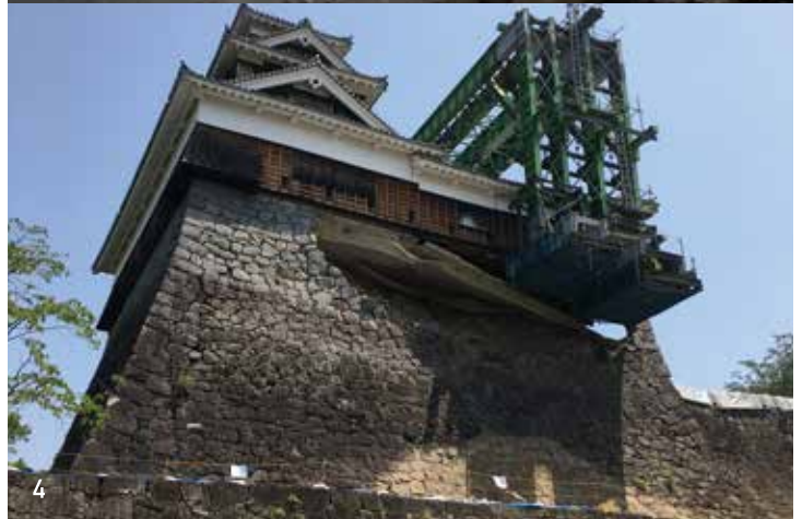
1. 崩壊した石垣は復元のために管理 2. 復旧が進む熊本城・天守閣 3. 震災後の頼当御門周辺 4. 飯田丸五階櫓の仮受構台
