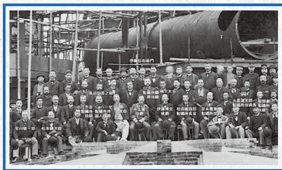
1900年(明治33年)、完成間近の東田第一高炉を背景に撮影された記念写真。第二高炉基礎上には当時侯爵だった伊藤博文や伯爵だった井上馨など、明治の産業革命を推進した英傑が揃う
