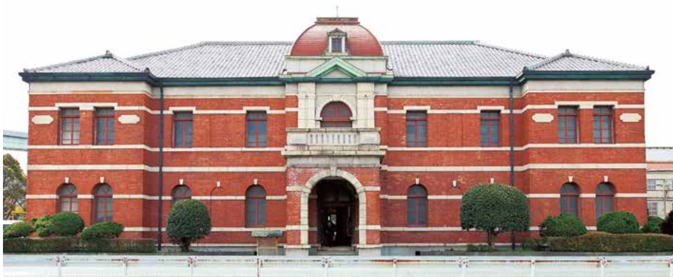
官営八幡製鐵所 旧本事務所
