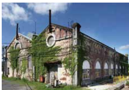
遠賀川水源ポンプ室 (新日鐵住金株式会社 八幡製鐵所 所蔵)
