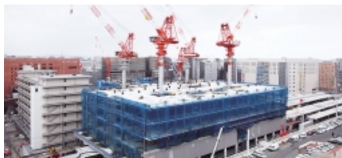
建設中の「新博多駅ビル」
