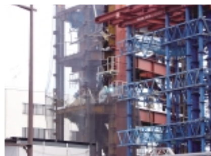
建設中の「FFG本社ビル」
