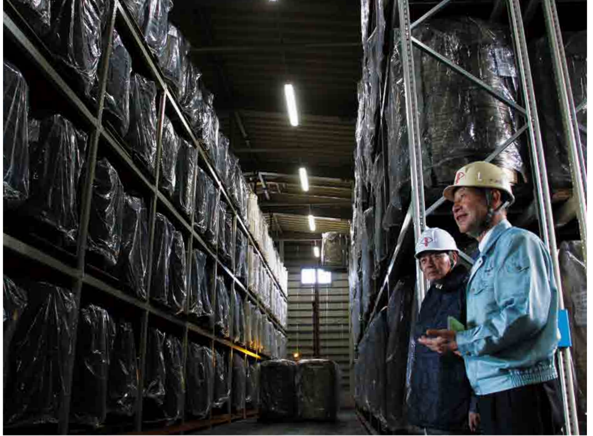
▲最新の設備が整った堺川ラック2号倉庫
