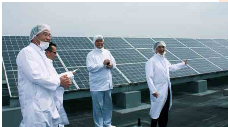
▲工場屋上に設置した太陽光発電パネルの視察風景
