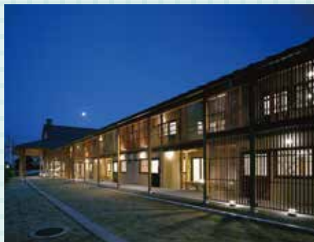
▲施工例（老人福祉施設）
