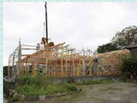
▲建設中の戸建住宅
