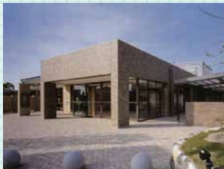
▲施工例（図書館）
