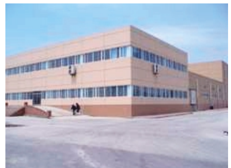
現地工場外観
