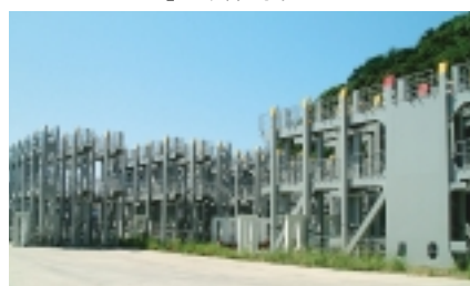
大型機装金物(ラッシングブリッジ)
