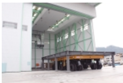
新設の塗装工場
