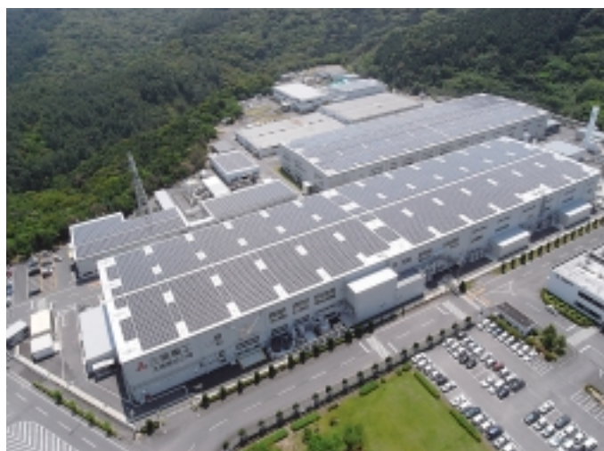
三菱重工諫早太陽電池工場の屋根に設置された太陽電池(500kW・800kW)
