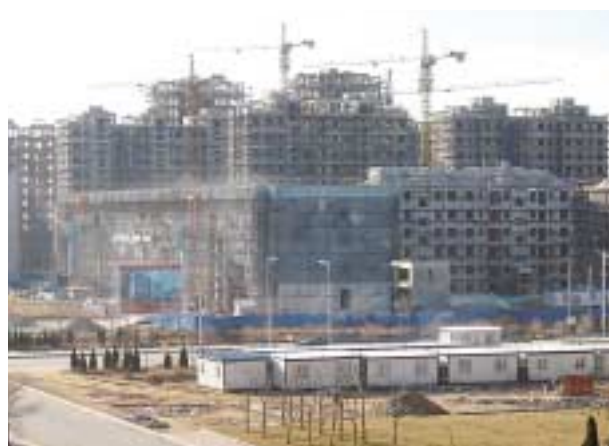
建設中の花園口経済区内風景
