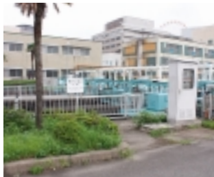
設備のメンテナンスを行った長崎市中部下処理場
