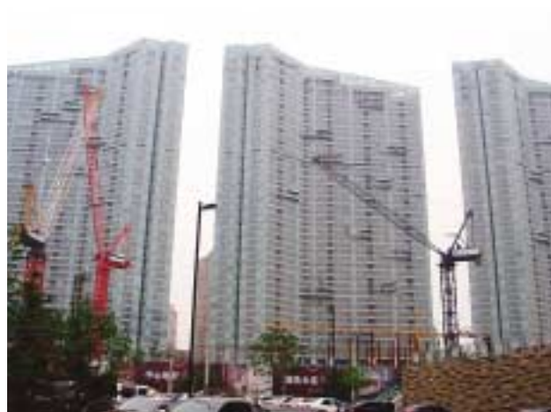
建設が進む高層マンション群
