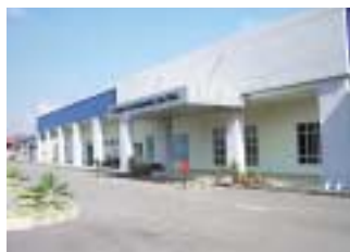
マレーシア工場
