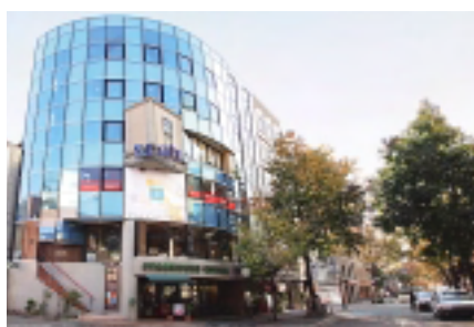
エストロウ九州本社ビル
