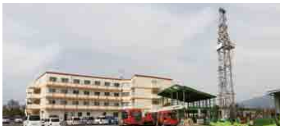
▲「太寿園」にて進む温泉掘削の様子
