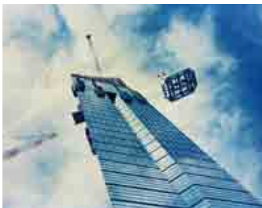
▲当社が手掛ける製品の例④ 福岡タワー用制震装置 (上段) と 福岡タワーへの設置の様子 (下段)
