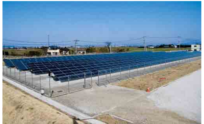
▲施工例（敷地設置）
