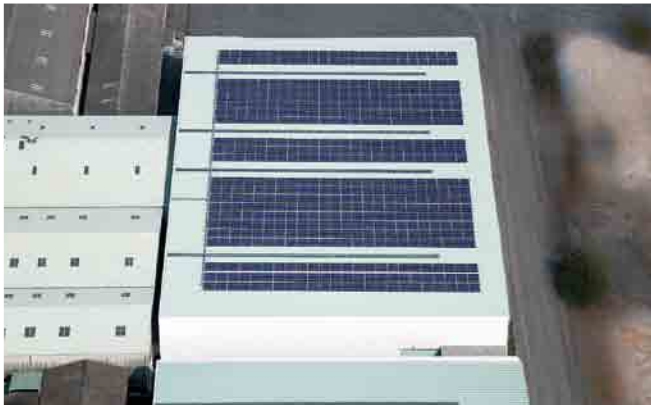
▲施工例（工場屋上設置）
