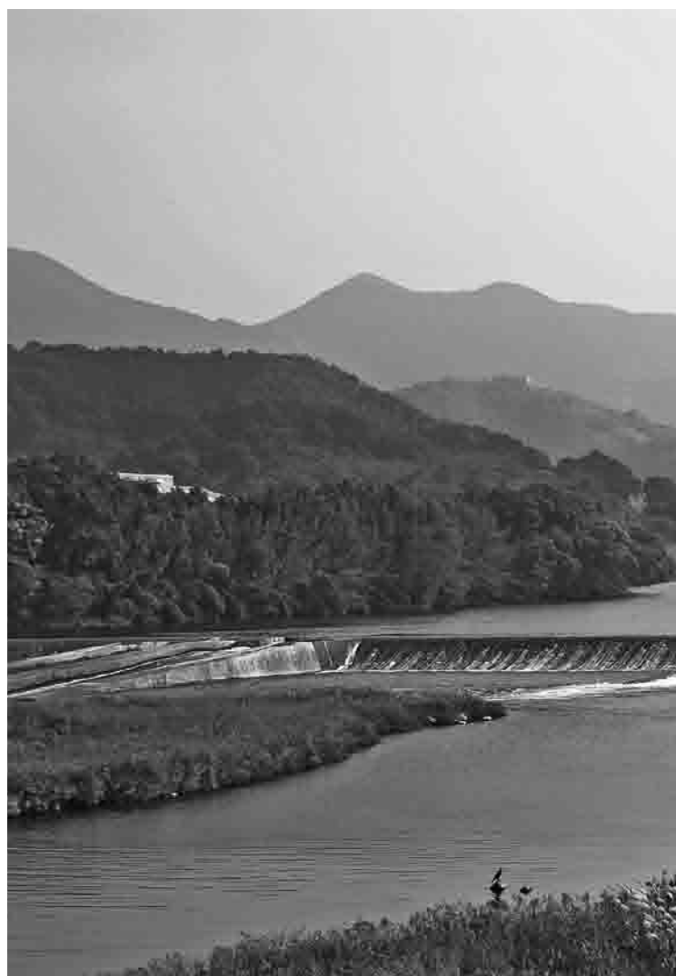
大石堰から取水された水は用水路を通り、いったん隈ノ上川に流れ込み長野堰から再び用水路を通して以西の村々に流れるように設計されていた。
