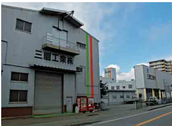
▲筑紫野工場外観
