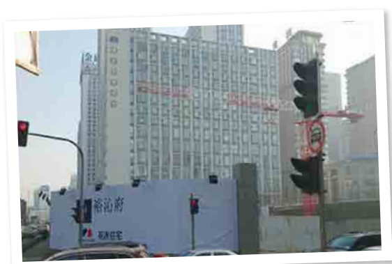
建設中の積水ハウス開発物件（ホテルやマンションからなる複合施設）
