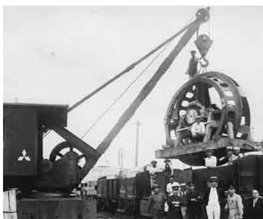
▲発電機の貨物積風景(昭和2年ごろ)
